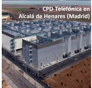
CPD Telefónica en Alcalá de Henares (Madrid)
