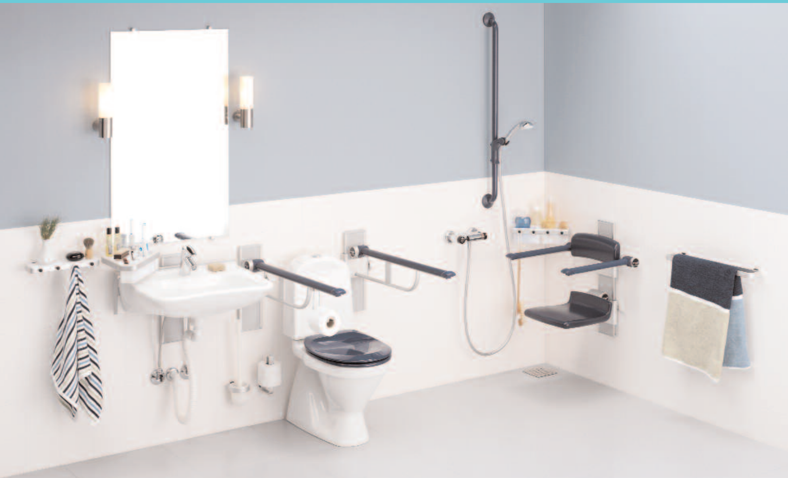
Cuarto de baño con ayudas técnicas desmontables, regulables verticalmente, para adaptarse a las necesidades de cada usuario
